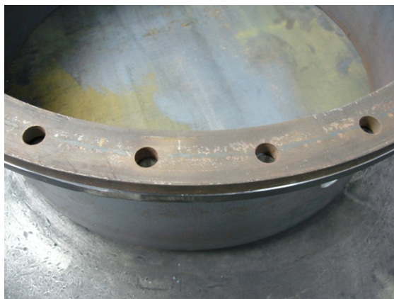
FIG.1) Collare passo d'uomo serbatoio esistente
