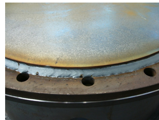
FIG.4) Saldatura a tenuta lungo la circonferenza del coperchio
